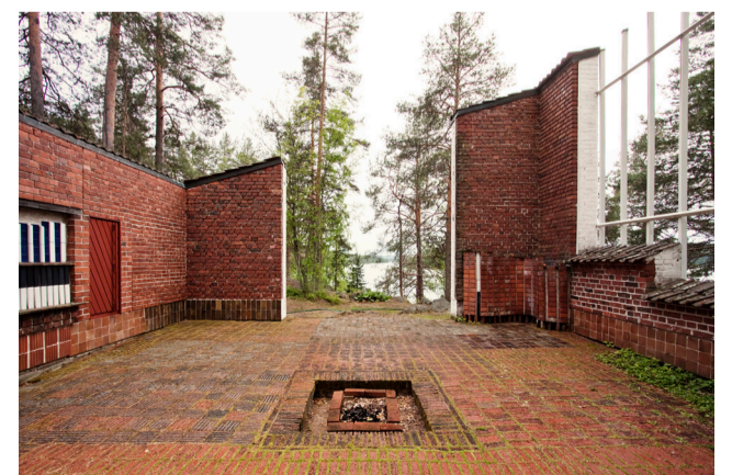
Alval Aalto - Muuratsalo; een omgevingsaanleg in bruinrode klinker en het gebruik van verschillende legpatronen en verschillende voegbreedtes beogen een bijzondere textuur voor het tapijt van Ettelgem.
