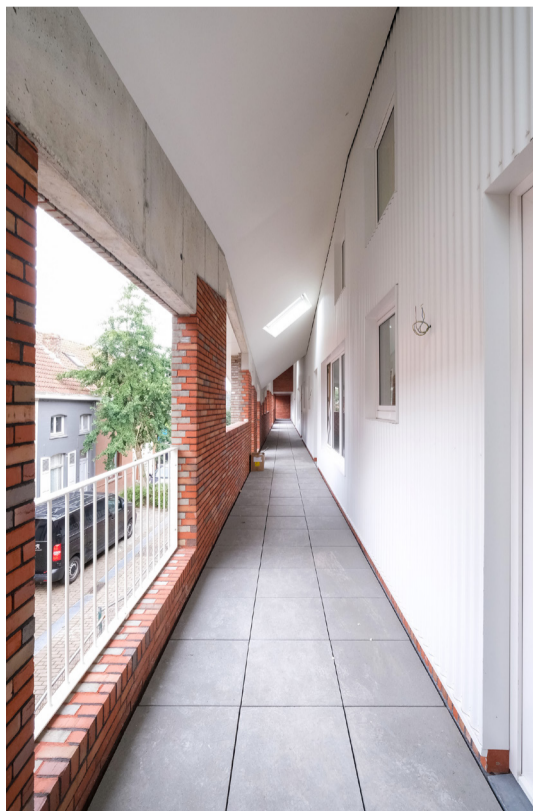
ampe.trybou – sociale woningen kaaistraat Gistel – combinatie massiefbouw en lichte invulling ifv economische optimalisatie
