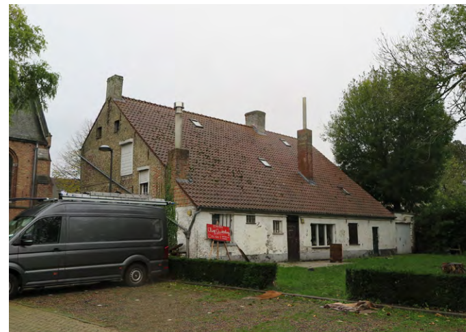
Met duurzaamheid in gedachten willen we de dakpannen van het parochiegebouw hergebruiken
